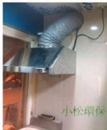
成功案列: 快餐店 裝設內容: MF型油煙處理機 煙罩 1HP直結式風機
