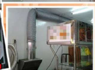
成功案列: 鹽酥雞排中和店 工程內容: TF型油煙異味處理機 1HP直結式風機
