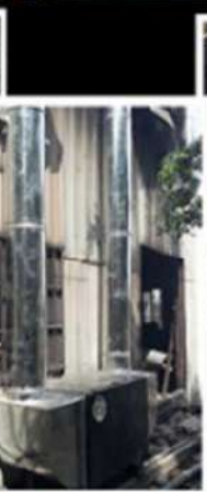
成功案例:豆腐加工廠 工程內容:TF油煙異味處理機 鍍鋅風管架設至樓頂
