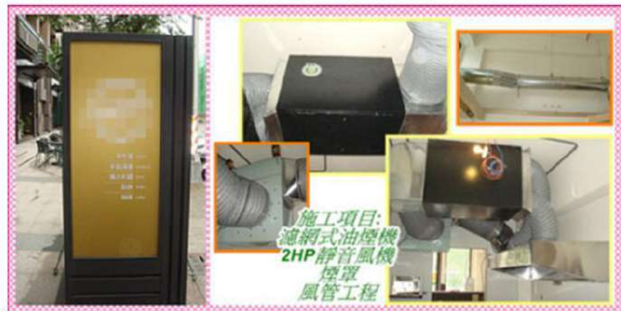
成功案列: 咖啡廚房 工程內容: TF型油煙異味處理機 1HP風機 煙罩
