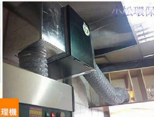
成功案列: 鹹酥雞 工程內容: TF型油煙異味處理機 煙罩 1HP風機
