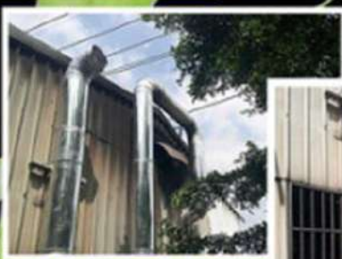
成功案例:豆腐加工廠 工程內容:TF油煙異味處理機 鍍鋅風管架設至樓頂
