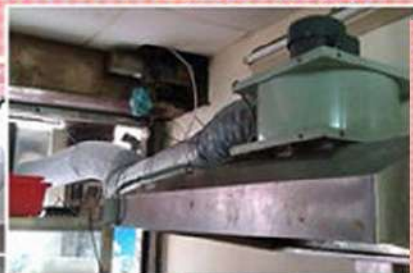
成功案例: 麻醬麵 施工內容: TF型油煙異味處理機. 煙罩. 1HP直結式風機
