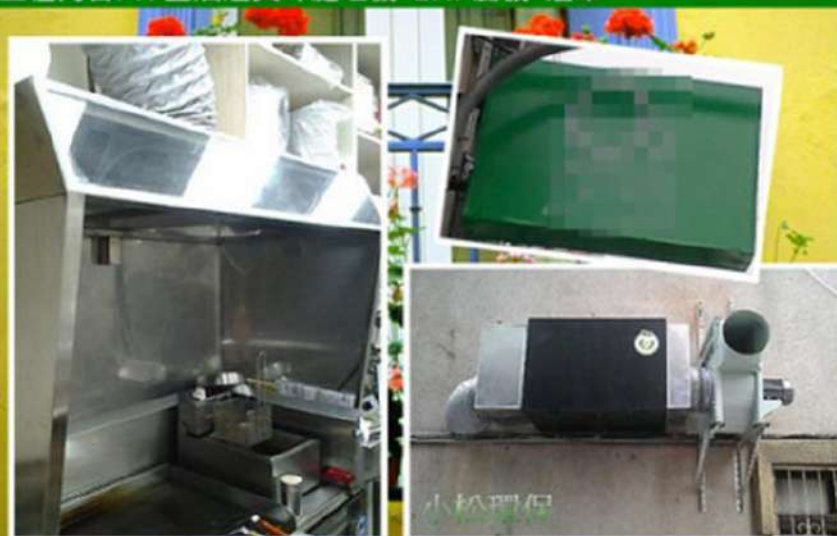
成功案列: 咖啡廚房 工程內容: TF型油煙異味處理機 1HP風機 煙罩
