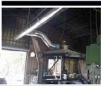
成功案例:飼料油加工廠 工程內容:TF型油煙異味處理機、鍍鋅風管架設至樓頂
