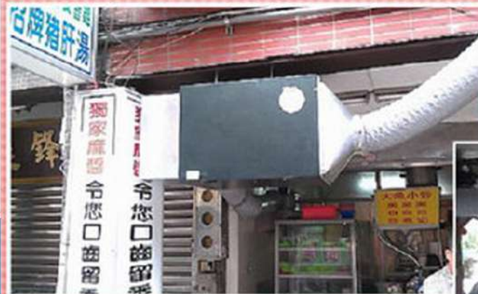
成功案例: 麻醬麵 施工內容: TF型油煙異味處理機. 煙罩. 1HP直結式風機
